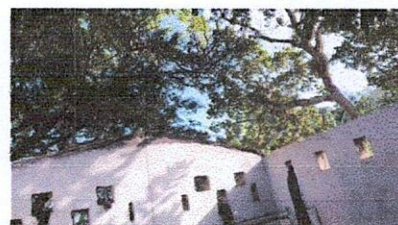
Foto 4: cambio de lamina en cocina
